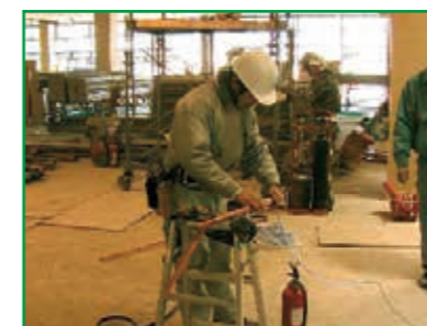
指定チューブを本体に接続し (ワンタッチ)、片方を銅管に挿入します。あとは電源 (100V) を入れるだけです。
